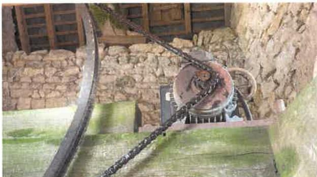
En conséquence il a fallu remplacer le moteur et réparer le battant qui tapait sur le bord de la cloche et qui risquait ainsi de la fissurer.
